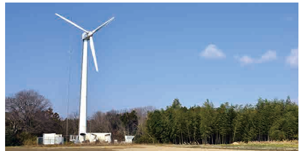
▲ 100kW風力発電装置
