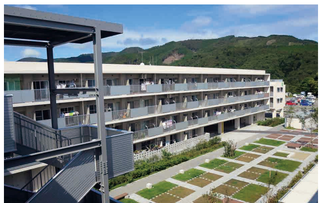
▲ 建設された災害公営住宅(東北地方)
