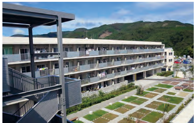
▲ 建設された災害公営住宅(東北地方)
