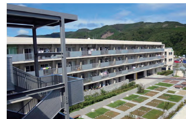
▲ 建設された災害公営住宅 (東北地方)
