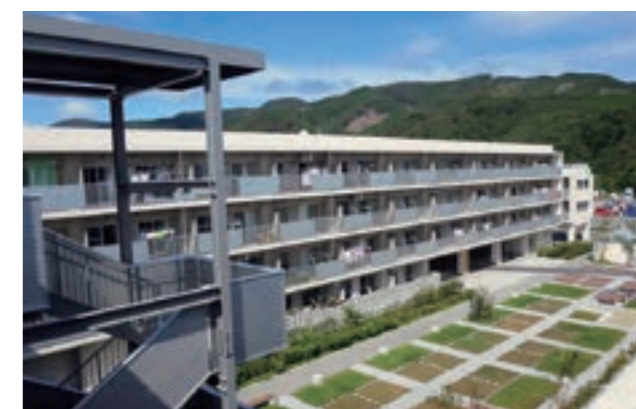
▲ 建設された災害公営住宅(東北地方)
