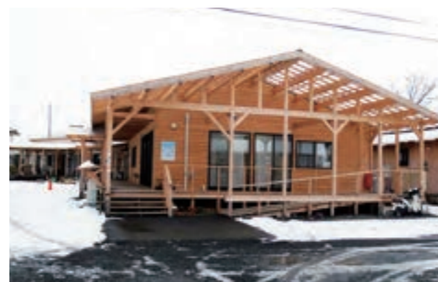
▲ 供給された木造応急仮設住宅(東北地方)
