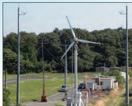
水平軸風車のフィールド実験
