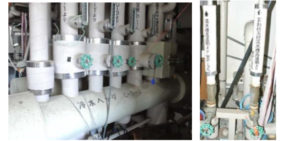
実験用蓄熱式空調システム
