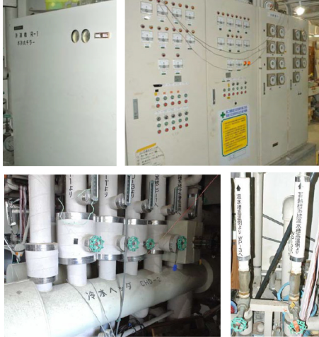
実験用蓄熱式空調システム
